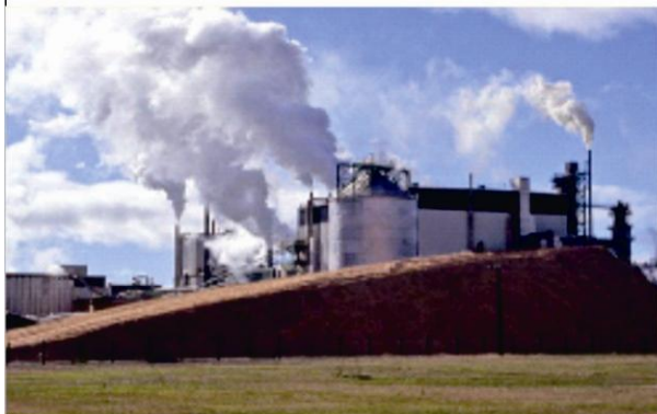
火电启动锅炉
