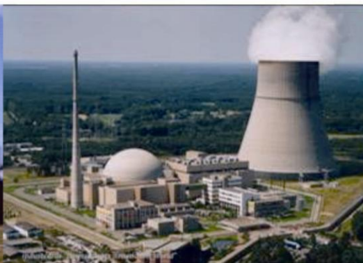
核电启动锅炉
