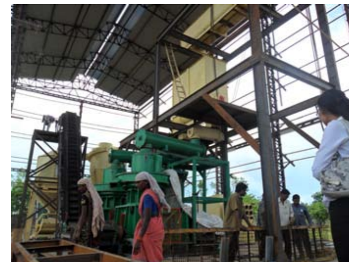
客户施工现场案例 Client Construction Site Case
