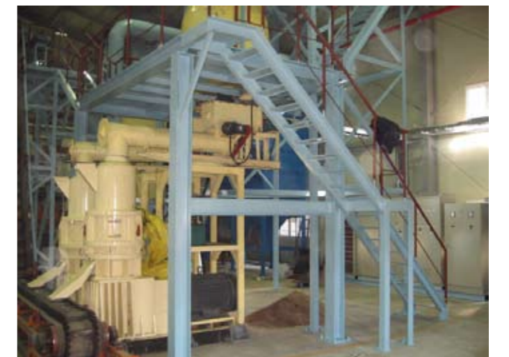
客户施工现场案例 Client Construction Site Case
