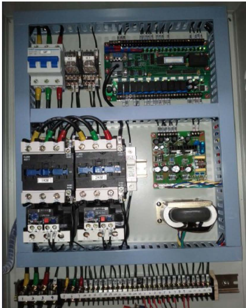
燃气锅炉燃烧器伺服电机：（风机联动、比例调节、紧急切断、故障报警）
