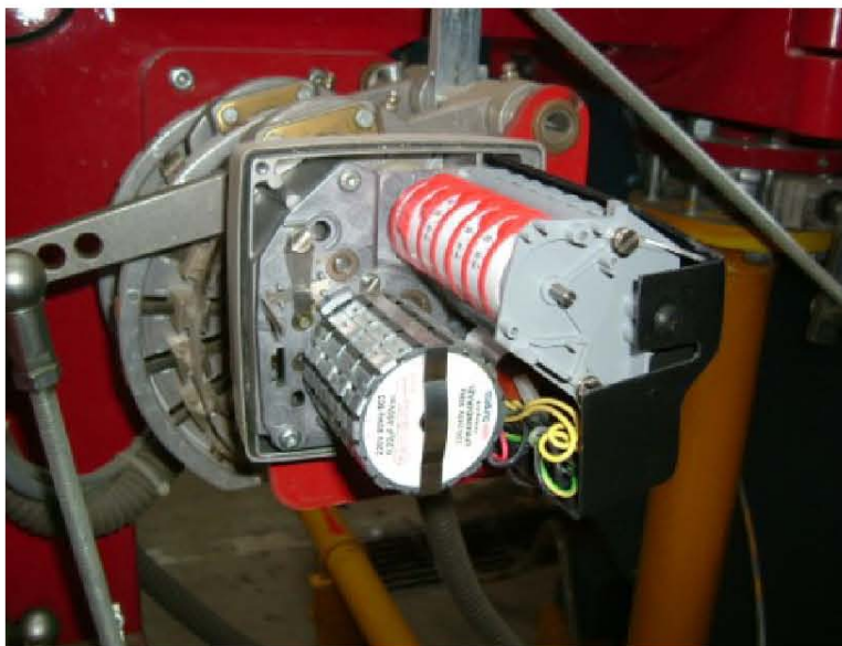
燃气锅炉燃烧器伺服电机：（风机联动、比例调节、紧急切断、故障报警）
