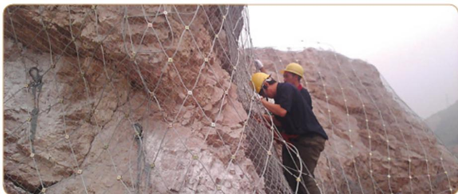
**材料:** 采用  $\Phi 8$  的钢丝绳 (抗拉强度为 1770Mpa, 破断拉力  $>40\text{KN}$ ) 编织, 并在结点处用专用“十字扣”固定而成, 为防护网的主要特征构件之一, 在主动防护中通过钢丝绳网的覆盖来实现边坡的加固, 其开放特征可以实现对 坡面天然植被和植被生长条件的最佳保护, 实现环境保护与灾害治理的有机结合; 在被动防护系统中, 其柔性特征充分体现了“以柔克刚”的思想, 实现崩塌落石的有效拦截。规格: DO/08/300/4x4
