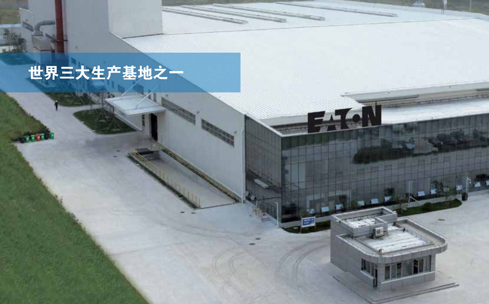
防爆电气常州工厂
