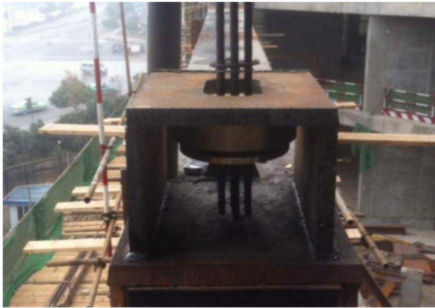
预紧钢绞线，采用 25T 单根千斤顶对每根钢绞线进行预紧。该千斤顶每 MPA 为 0.5 吨，每根钢绞线预紧压力拉到 3MPA 即可。（或用 3 吨手葫芦拉紧钢绞线）
