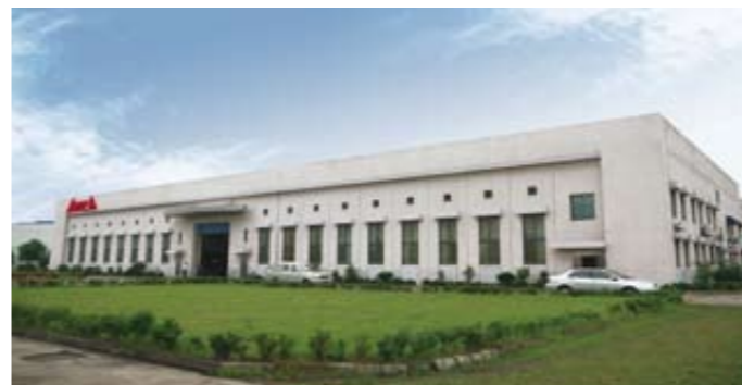
蘇州達崴機電 ■ 大型零組件加工 / 13,884 m 2
