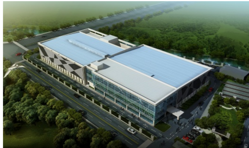
■ 泽国沈桥厂房
