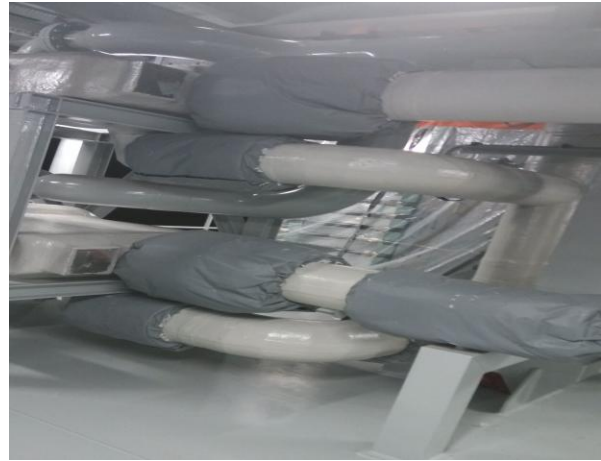
LNG 系统保温
