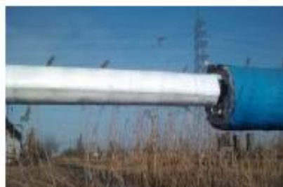
新疆克拉玛依油田稠油开采，管道介质330℃，气凝胶毡的厚度仅为传统硅酸铝材料用量的1/4。
