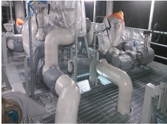
LNG 系统保温
