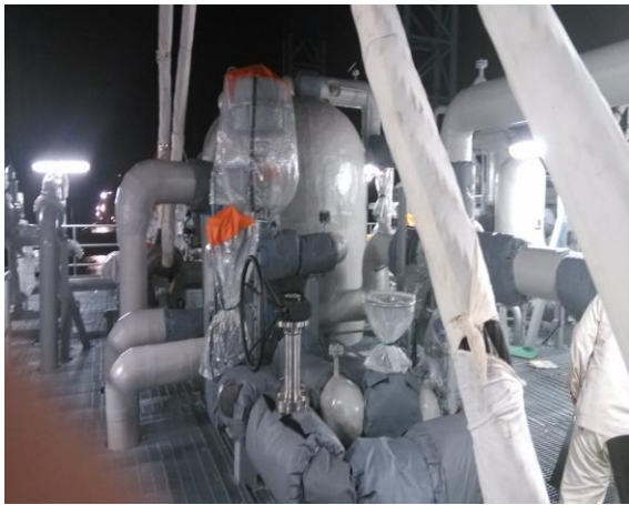
LNG 系统保温
