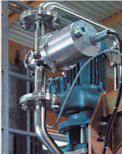
使用循环泵在外循环管道上的安装
