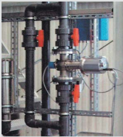
在线安装 (旁通)
