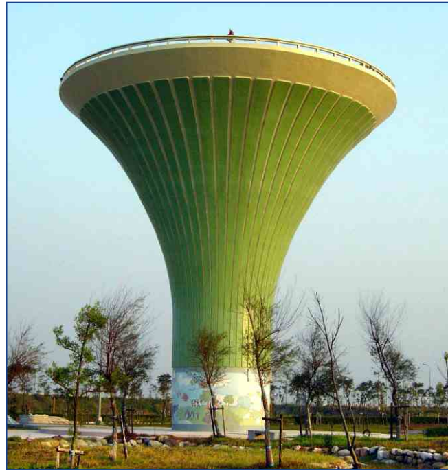
500吨高架水塔-完成后
