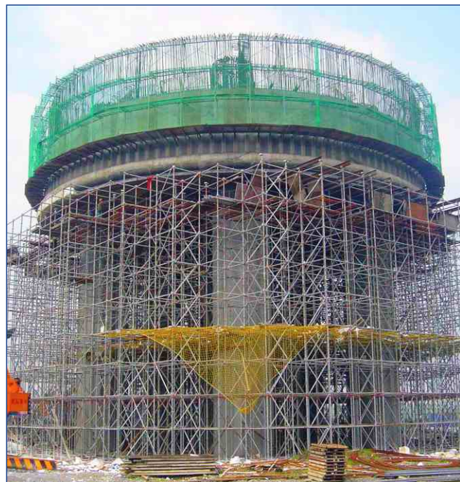
3000吨高架水塔-建设中
