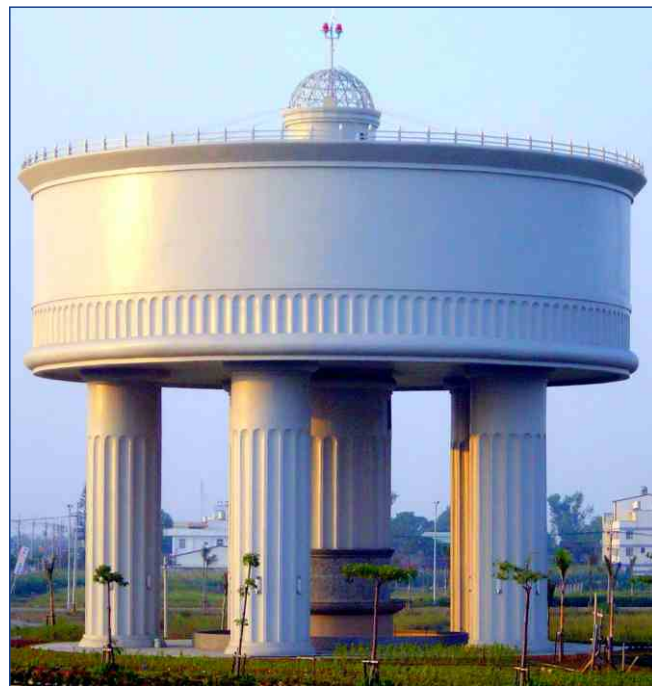
3000吨高架水塔-完成后
