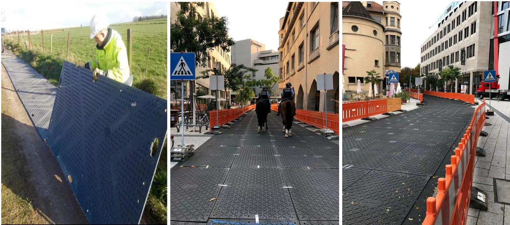
产品与钢铁，铝合金，木材所制传统产品相比具有运输成本低，性价比高，产品抗氧化抗老化性能高，耐磨耐腐蚀，防静电，绝缘性能高，机械强度和物理韧性结合完美，使用寿命长，对机械设备以及运输车辆保护性强，施工人员安全性高等一系列优势。
