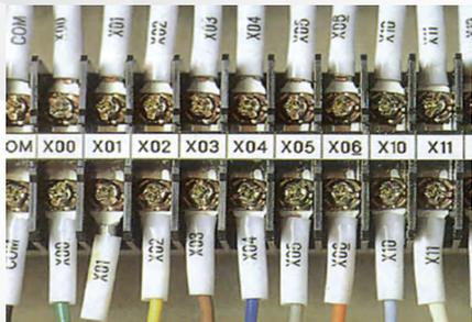
套管及热缩管打印
