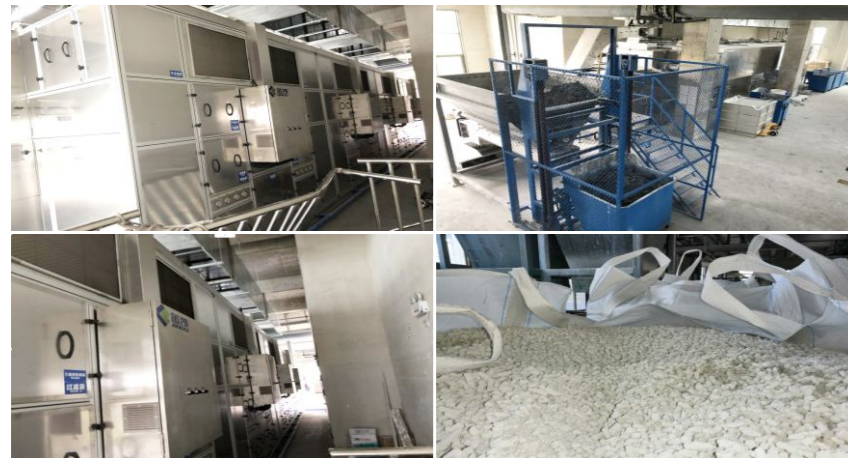
日凯电脑配件有限公司 (盐城) 污泥类型:电镀污泥 前端压滤:板框压滤机 湿泥量:15吨/天 湿泥含水率:75% 干泥含水率:30% 产品型号:JK-LSX9600WN
