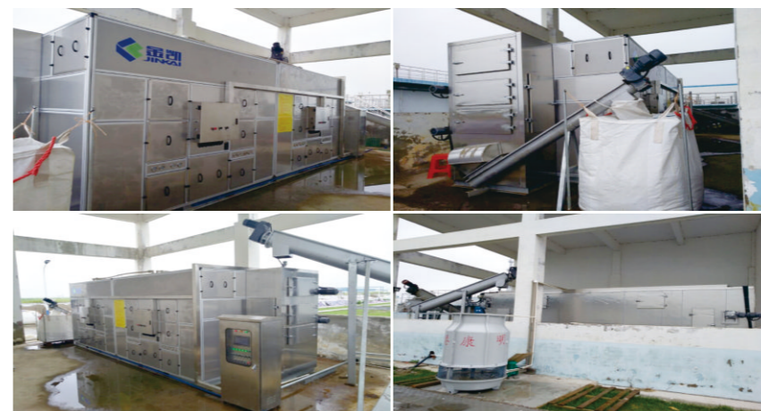
凯泉（洋口港）污水处理厂 污泥类型：工业污泥 前端压滤：离心脱水机 湿泥量：6吨/天 湿泥含水率：80% 干泥含水率：30% 产品型号：JK-LSX4800WN
