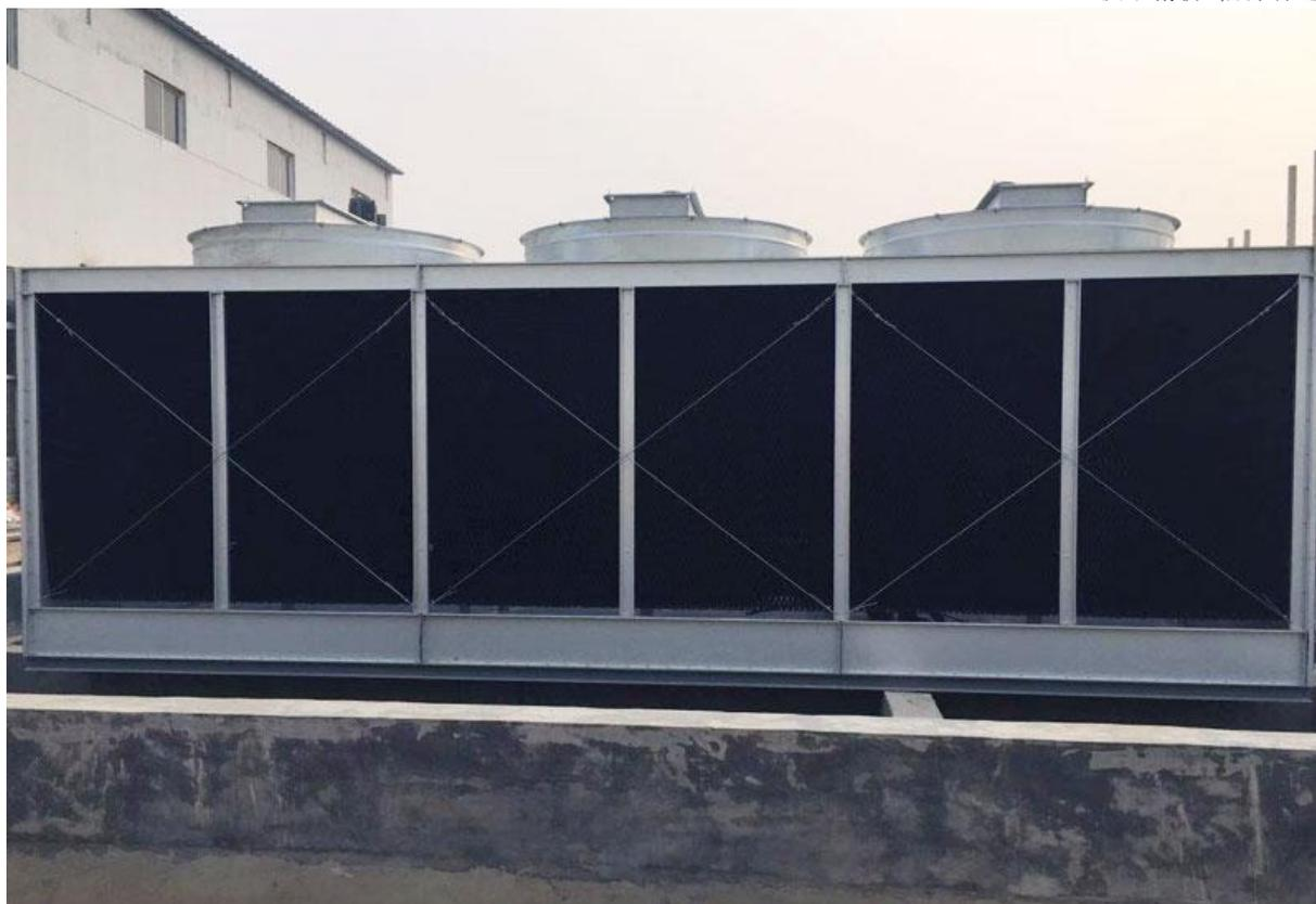
钢式开塔分为横流钢式开塔和逆流钢式开塔，是利用水和空气的直接接触，通过蒸发作用来散去工业上或制冷空调中产生的废热的一种设备。
