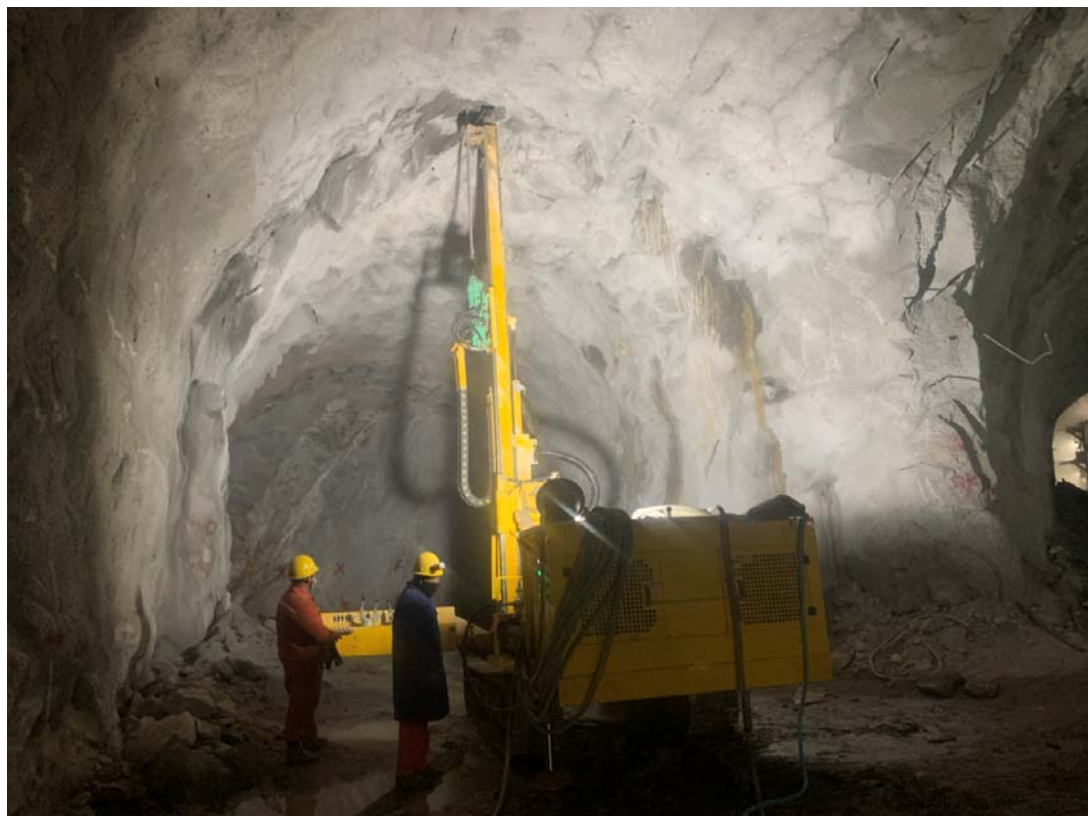
系统锚杆施工
