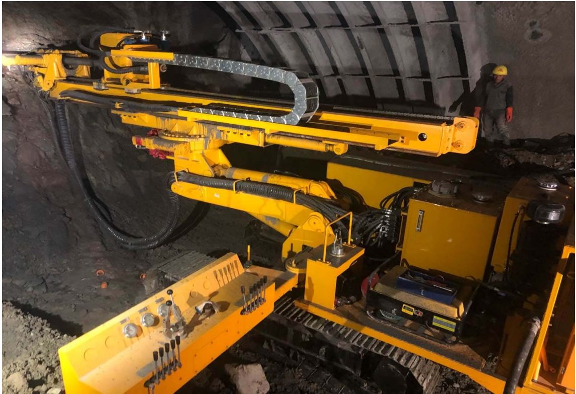
超前探孔施工
