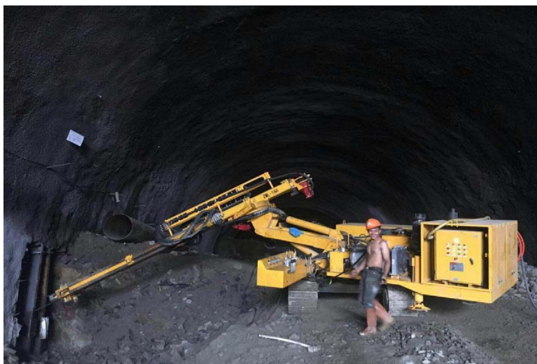
锁脚锚杆施工
