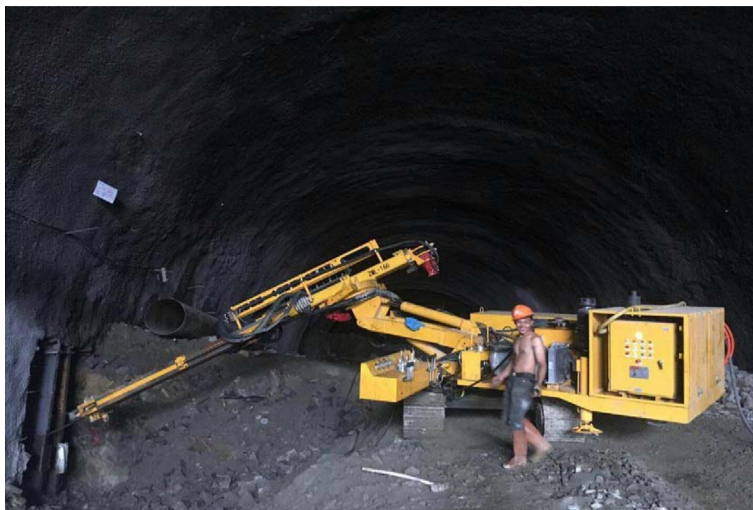
锁脚锚杆施工
