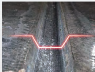
管道中V型槽检测
