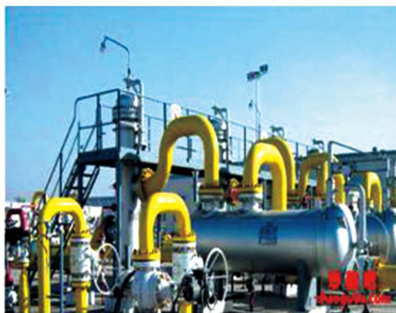
▲ 燃气场站工程
