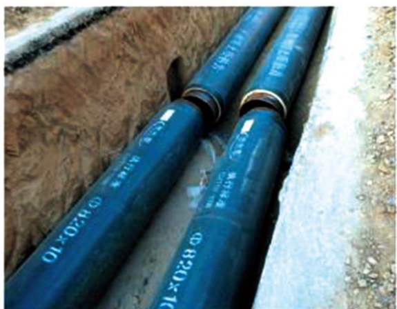
▲ 城市供暖工程
