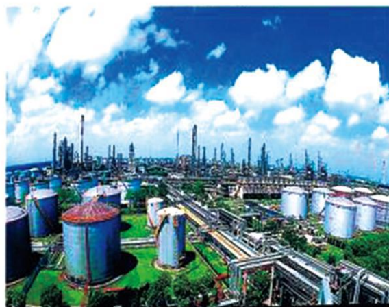
▲ 石化建设工程
