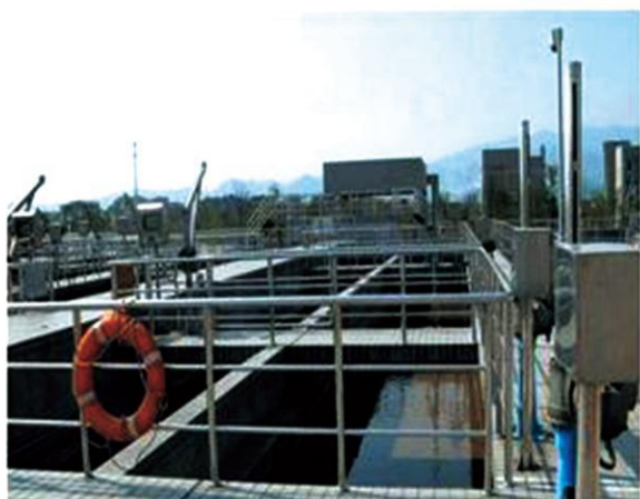
▲ 污水处理工程
