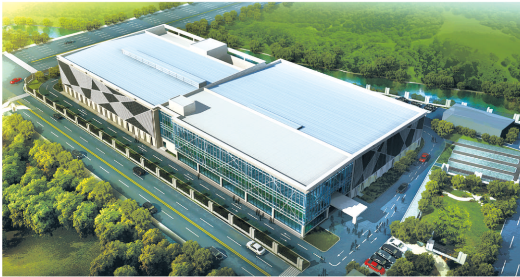
■ 泽国沈桥厂房
