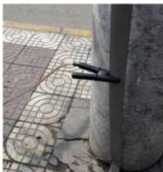
图 9 连接接地端
