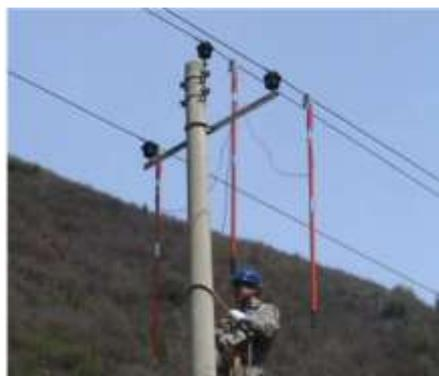
图 13 信号输出线挂接
