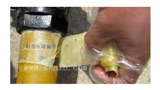
5、根据管道压力缠绕,按照每层抵挡压力1公斤(0.1MPa)缠绕圈数;
