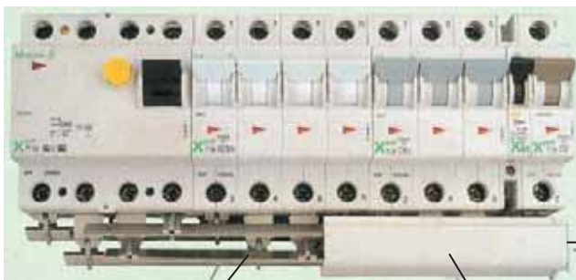
ZV-L1 /N (-80A)对L1和N的接线角度相同, 180°旋转
