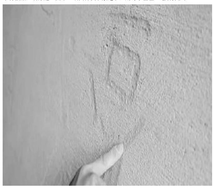
水泥砂浆抹灰墙面跑沙一蹭就掉砂用什么方法治理?
