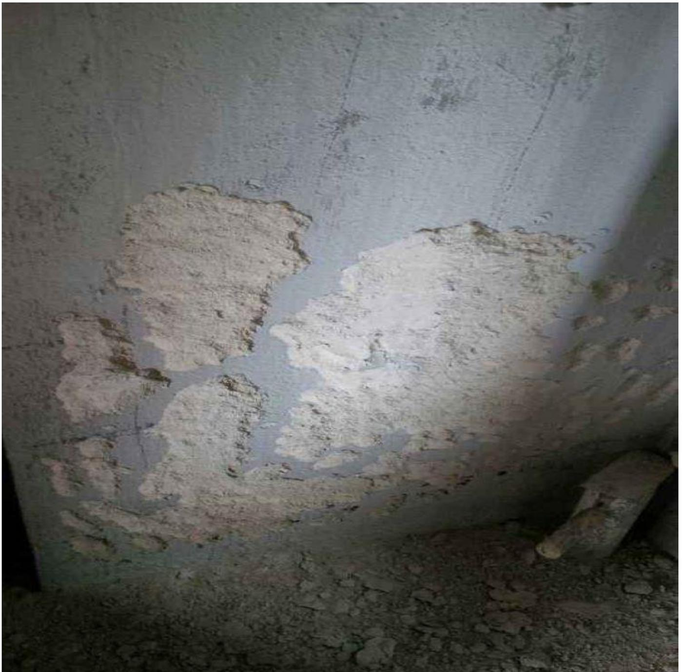
香樟公馆的几位业主有点发愁，新房终于到手，装修过半却不敢再装修下去了，因为他们发现墙面用手轻轻抹一抹砂浆层，沙渣就“沙沙”落下。这样的情况并非个例。随手拿起地面上的一个起子，往墙上一戳，白色的腻子连块掉下，漏出灰色的砂浆层。用手一抹，大量灰色的沙沿着墙面落下，验房师席师傅也只是用手掌抹了几下墙面，就带掉了大量的砂灰。
