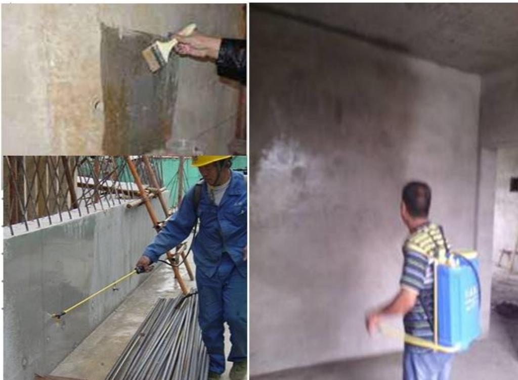
晨中墙砭剂并非一般意义的像胶水那样把松散的砂子临时粘在一起，因此材料效果是永久效果的，同时不仅可解决墙面掉沙脱灰，还可防老化、减少 ASR 碱骨料反应。对于旧墙翻新过程中发现基层墙面脱沙同样有效。不同的墙面，因造成脱沙的程度不同及造成的原因不同，材料用量或效果有些差异是正常的。非胶水、表层结膜类材料符合环保要求、无毒无味。装潢设计装修翻新时可放心使用。
