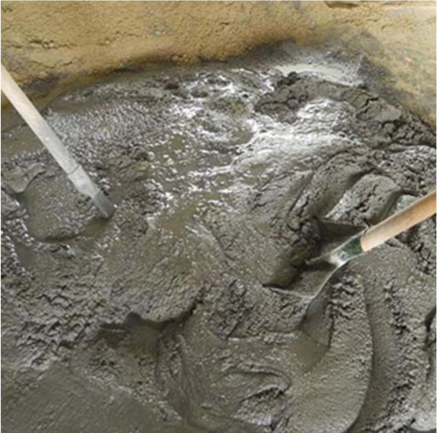
2) 选用与外加剂相容性好的硅酸盐水泥或普通硅酸盐水泥，水泥与外加剂相容性差，造成混凝土后期严重的滞后泌水，甚至形成“鱼塘”，造成混凝土表面层水胶比很大，表层混凝土强度很低。禁止使用过期、受潮、劣质水泥，其强度、硬度及耐磨性能都会下降，容易使墙面出现起砂现象。
