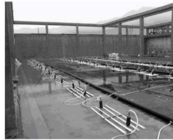
● 无极综合污水处理厂 8万吨/日
